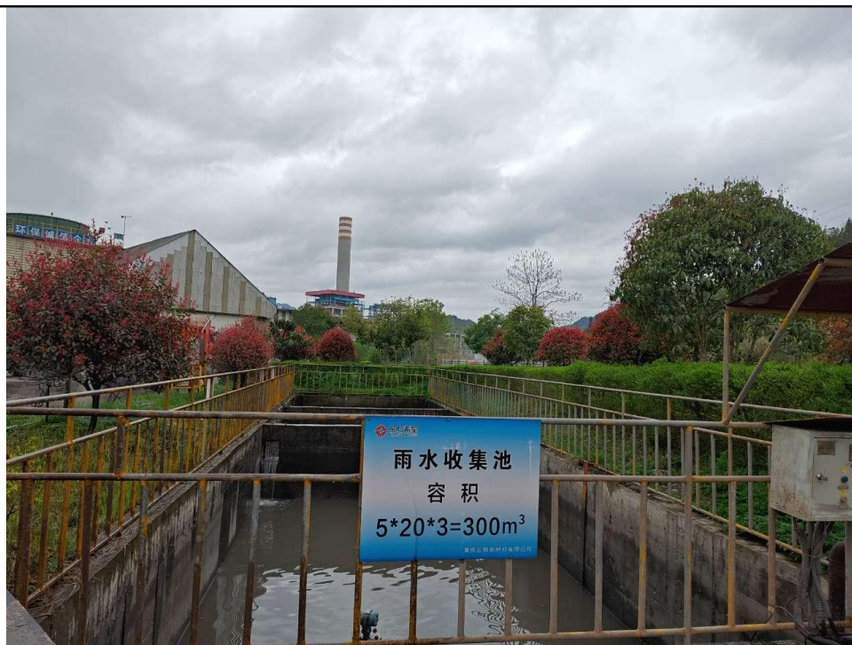
图 2.3-6 厂区初期雨水收集池
