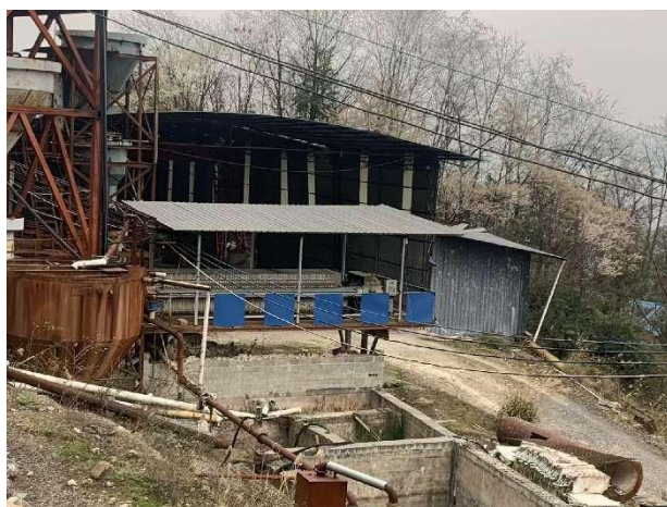
泥沙分离塔及泥沙分离沉底池 (DCD4)
