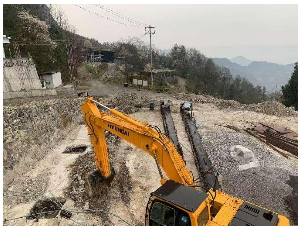
破碎加工 (彩钢棚现状已拆除正在重新搭建)
