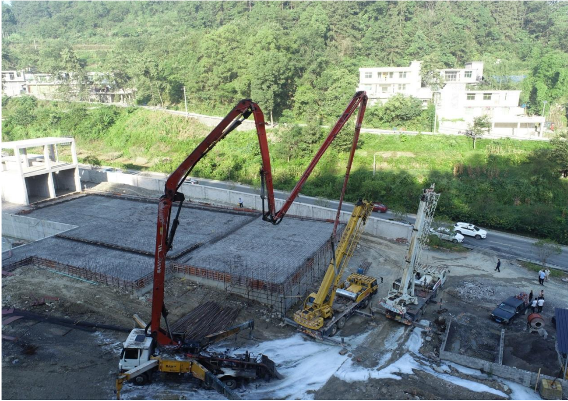
事故现场远景图（事故泵车准备给右侧建筑浇筑混凝土）
