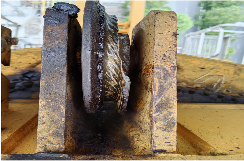
图四：1#塔机过度节主钢丝绳转向滑轮（近景图）
