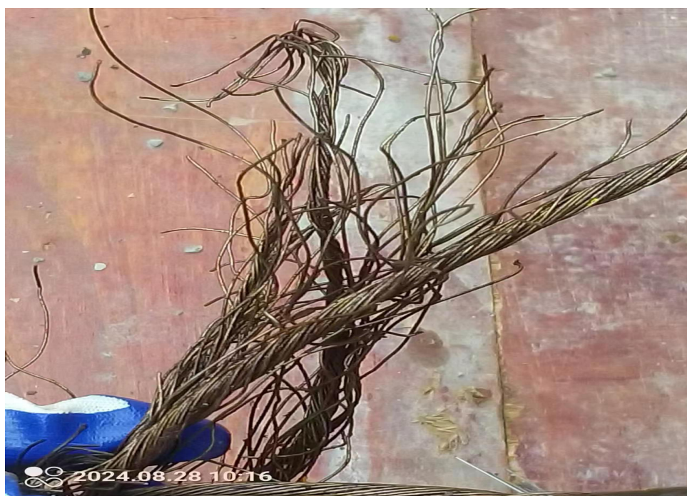
图三：1#塔机过度节主钢丝绳断裂处
