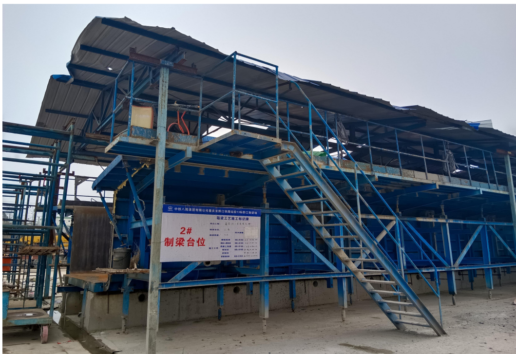
图二：2号制梁台近景图
